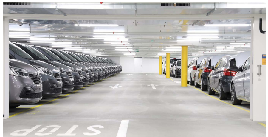
Modernes Car House mit LED Beleuchtung
