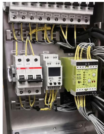
Los relés de supervisión multifunción garantizan el suministro eléctrico y protegen la electrónica del vehículo.
