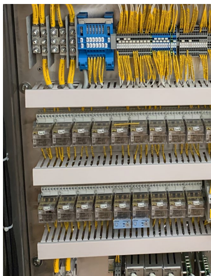
Los módulos de tiempo controlan de forma fiable los procesos dependientes del tiempo y contribuyen así a la seguridad del control de trenes.
