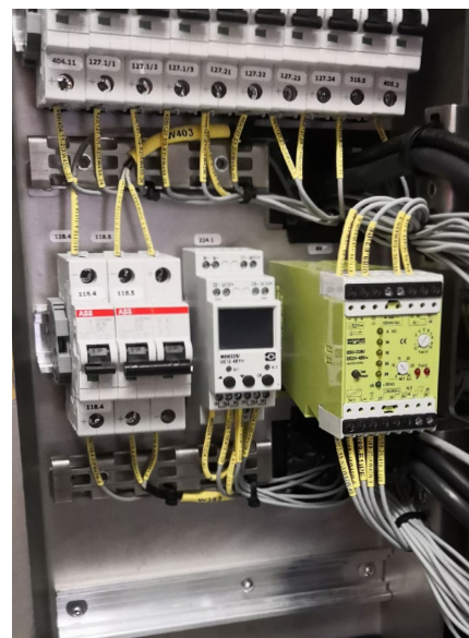
I relè di monitoraggio multifunzione garantiscono l'alimentazione elettrica e proteggono l'elettronica del veicolo.
