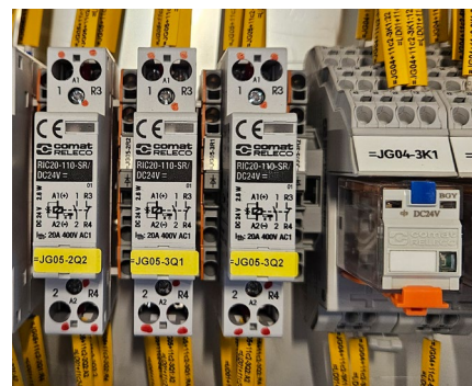
Contacteur ferroviaire RIC destiné à la commande de relais de commande de moteur pour diverses applications
