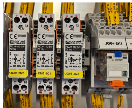
Contattore ferroviario RIC per il comando di relè di controllo motori in diverse applicazioni
