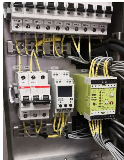
Les relais de surveillance multifonctions assurent l'alimentation électrique et protègent l'électronique du véhicule.
