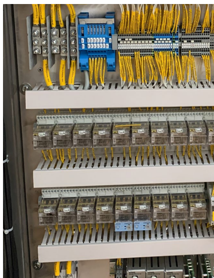
Les modules temporels commandent de manière fiable les processus dépendants du temps et contribuent ainsi à la sécurité de la commande des trains.
