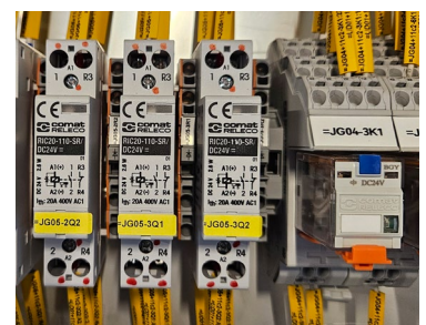
RIC-Bahnschutz zur Ansteuerung von Motorsteuerrelais für verschiedene Anwendungen
