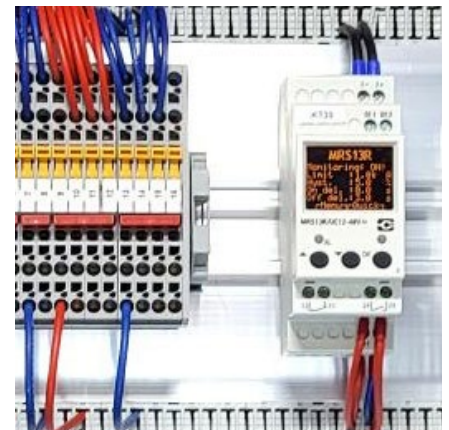
Le MRS13R surveille les courants et protège de manière fiable contre les surcharges et les courts-circuits.
