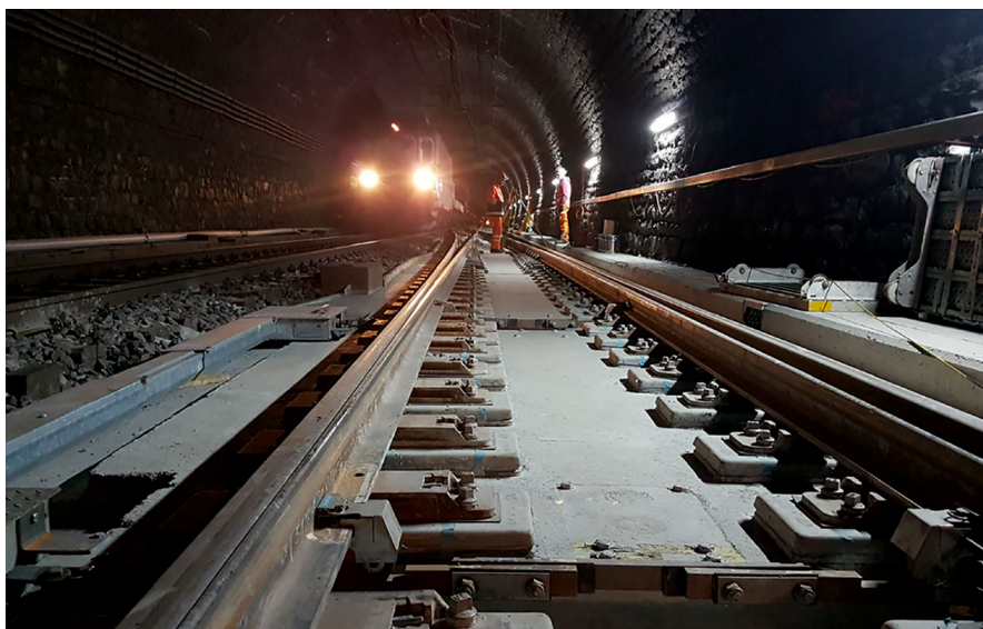
La terrasse en ballast est remplacée par une base en béton. Les trains extra-larges mettraient en danger la sécurité sur le chantier et doivent être stoppés.
