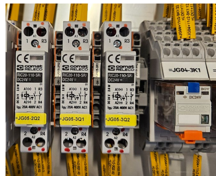
Contactador ferroviario RIC para el control de relés de control de motores para diversas aplicaciones
