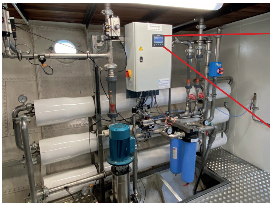
V430 SPS zur Steuerung der Umkehrosmoseanlage für die Wassererzeugung der «Stadt Rapperswil» der ZSG.
